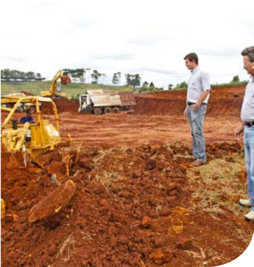
Unidade de Zortéa está sendo construída. Terraplanagem foi concluída em 2011
