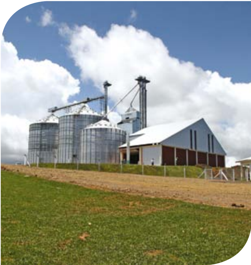
Obras da filial de Lebon Régis está em fase final
