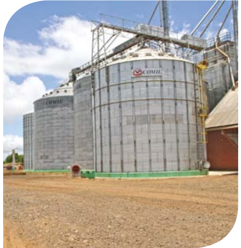
Na unidade de Guarda-Mor em Curitibaanos dois novos silos foram construídos
