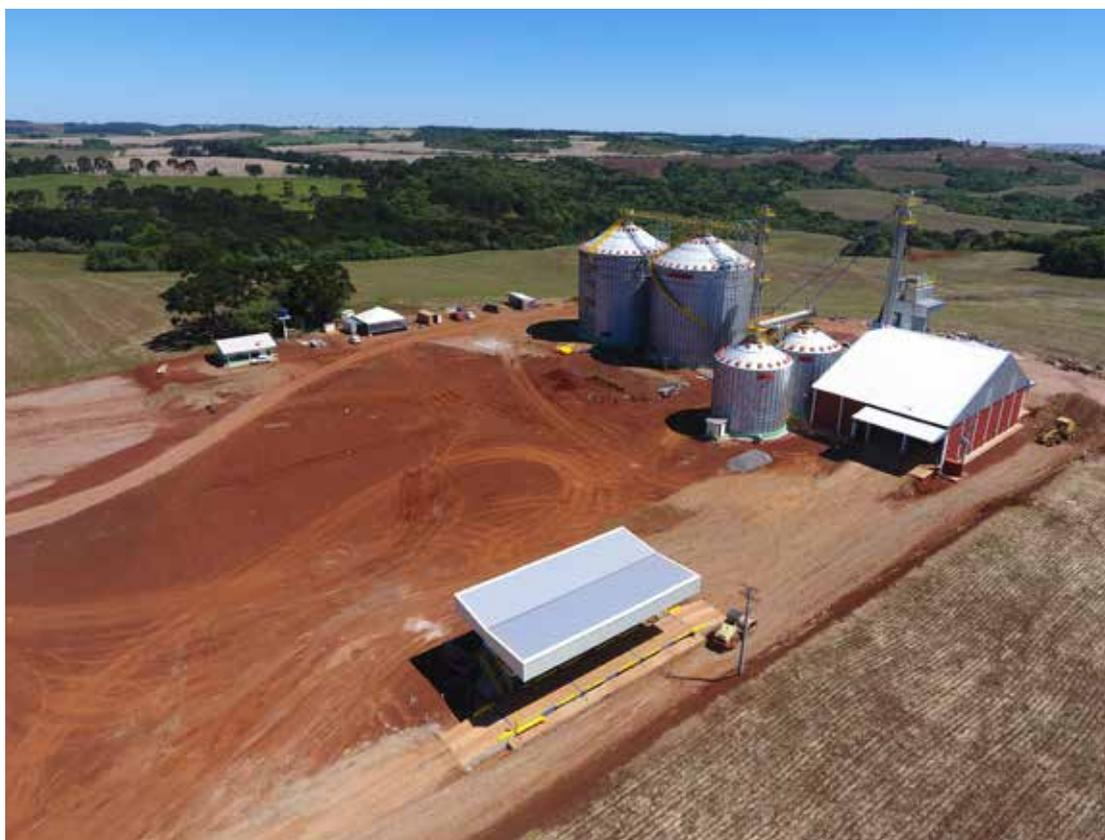
**A**s obras na unidade de armazenagem de grãos de Esmeralda/RS, com capacidade de armazenagem de 240 mil sacos/60kg de grãos serão finalizadas em 2019. As obras nas duas moegas de recebimento, instalação de tombador e balança já foram finalizados. Os dois silos de 100 mil sacos/60kg cada, assim como os dois silos pulmão de 20 mil sacos cada, também já foram finalizadas, restando apenas a finalização de instalações de equipamentos, como o secador, além de cascalhamento do pátio.
