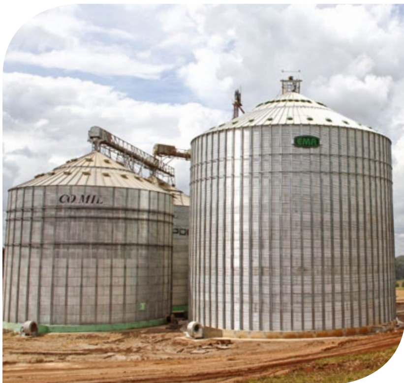
Unidade 42 – Brunópolis um silo com capacidade de recebimento de 100 mil sacos/60kg já está em funcionamento
