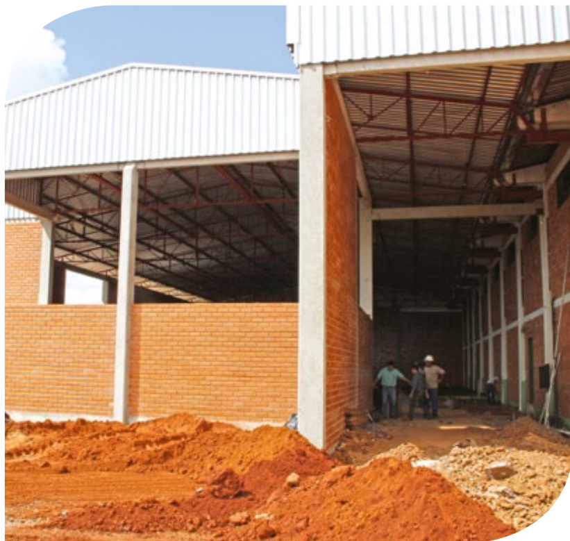
Armazém de fundo plano foi construído na filial 47 – Trevo Sul. No local será instalada uma Unidade de Beneficiamento de Sementes (UBS)
