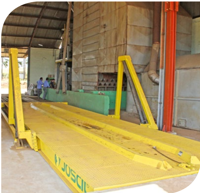
Na filial 48 – Barracão um novo tombador, uma máquina de secagem e um novo elevador foram construídos
