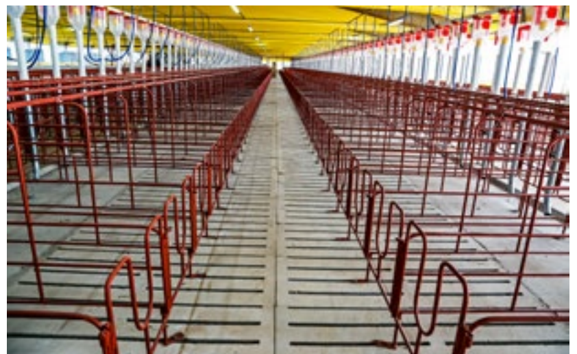
Equipamentos estão sendo instalados no sítio 1 da granja.
