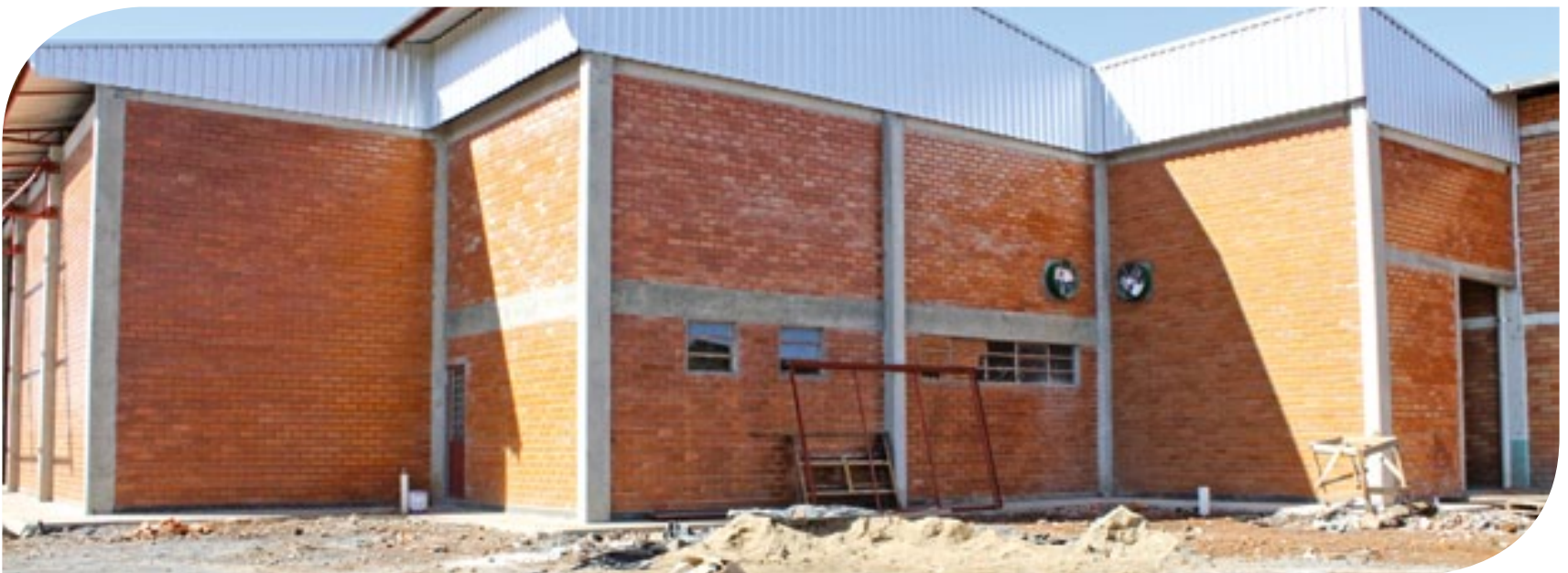
Na filial 47, um novo armazém foi construído e uma CTS foi instalada. A Central atende os padrões exigidos para o tratamento de sementes
