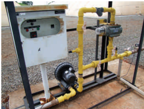
Medidor do gás metano proveniente do biodigestor
