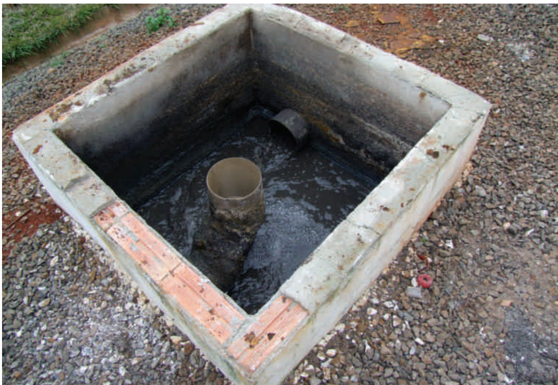
Entrada do efluente no biodigestor
