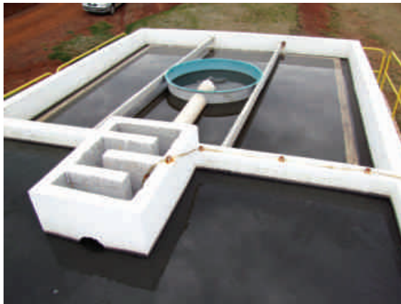
Tratamento de efluentes no decantador
